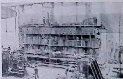
Motor Sulzer de 7.300 BHP., construido en España.
